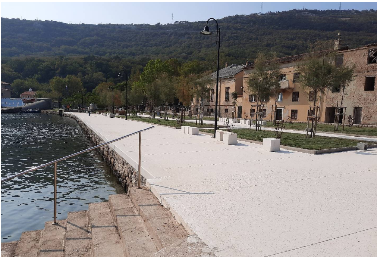
Slika 2.6 Pogled sa sjeverne strane na predmetni zahvat – rekonstruirani obalni zid, u zaleđu nedavno uređeni dio Parka Banj
