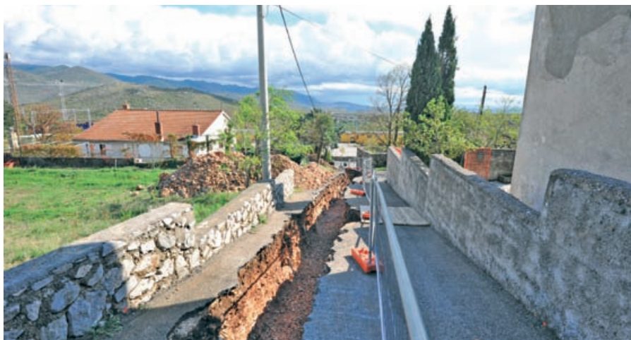
Izgradnja vodovodnog ogranka kod škrljevskog ščaciona
