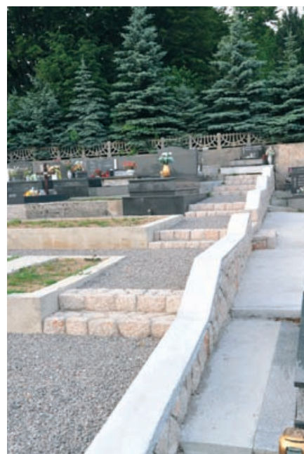
Izgrađeni zidovi i pješačke staze na groblju u Zlobinu
