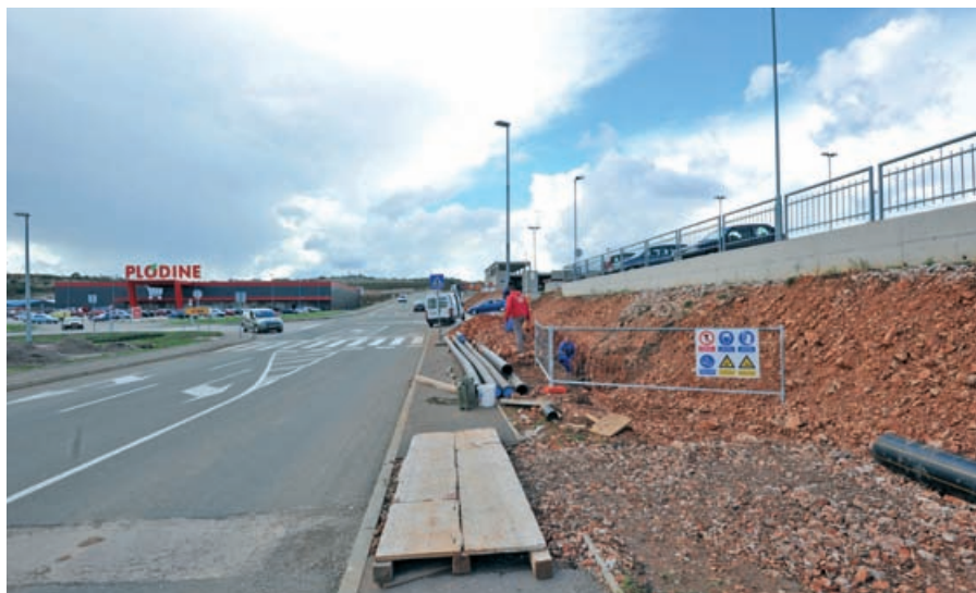
Značajni radovi - uskoro dovršetak prve faze plinifikacije Zone
