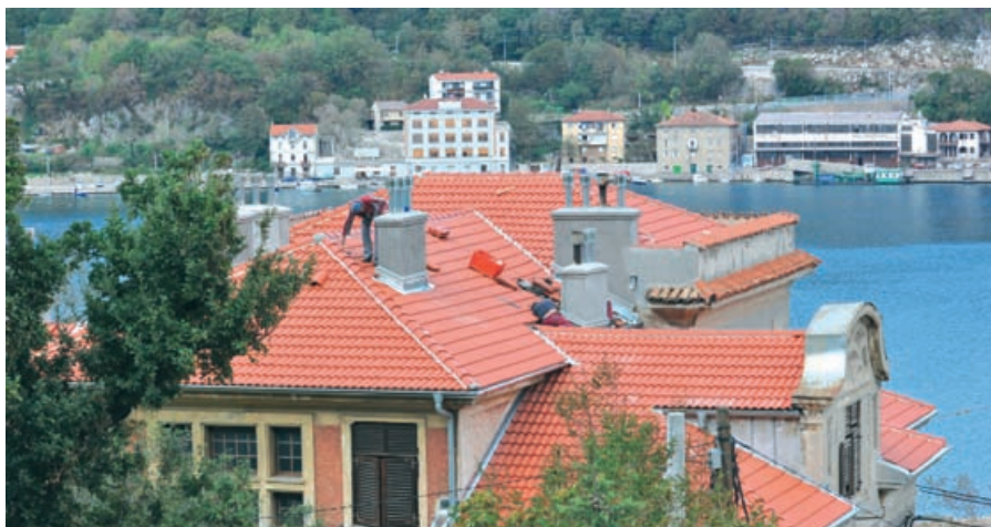
Novo krovište na zgradi nekadašnjeg Staračkog doma
