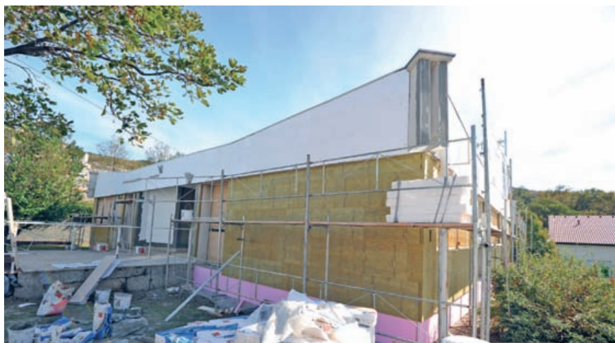
Radovi na uređenju zdravstvene stanice u Hreljinu
