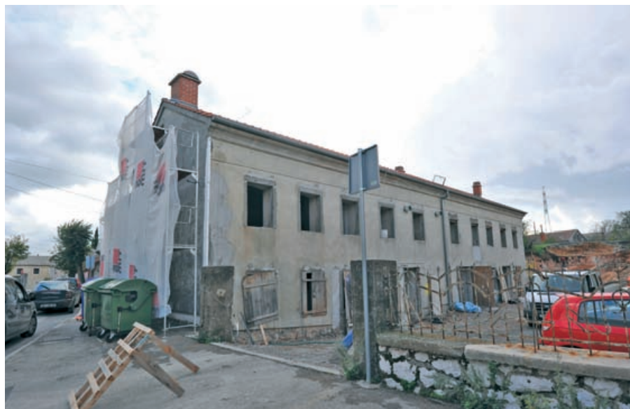
Radovi na rekonstrukciji i uređenju nove ambulante u Krasicici
