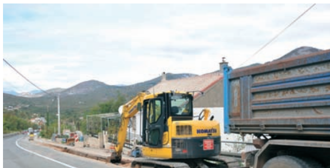
Izgradnja novih vodovodnih ogranaka u Hreljinu
