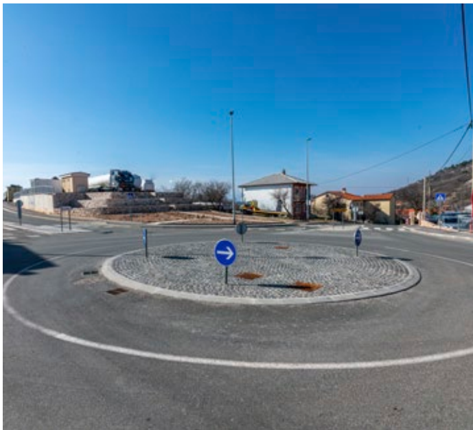
Izgrađeno kružno raskrižje na Meji
