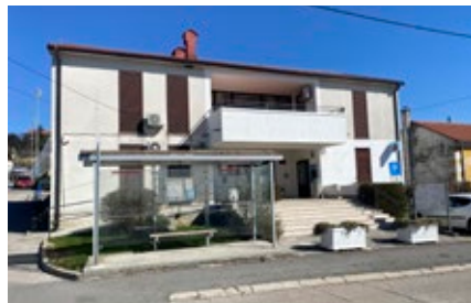
Novi krov i uređeno pročelje zgrade VMO Krasica
