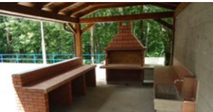
Izgrađena nadstrešnica s vanjskom kuhinjom i kaminom u dvorištu Doma kulture Zlobin
