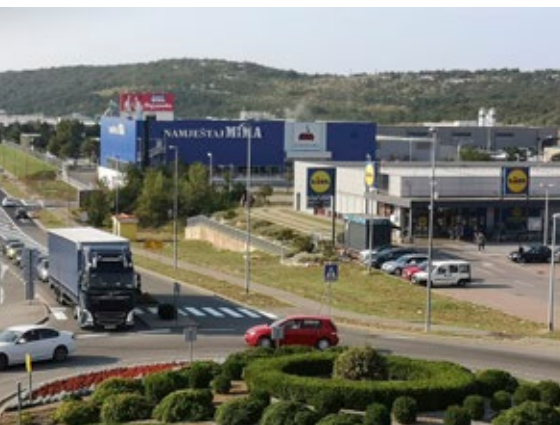
Izvršena rekonstrukcija glavne prometnice u Industrijskoj zoni Bakar
