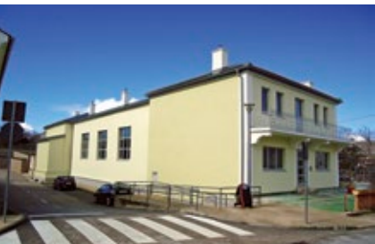
Obnovljena fasada i stolarija Doma kulture Krasica
